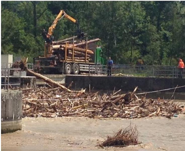
Beim Aare-Laufkraftwerk Flumenthal (SO) wurde so viel Schwemmholz wie möglich aus dem Wasser geholt, damit die Aare ungehindert abfließen kann.
